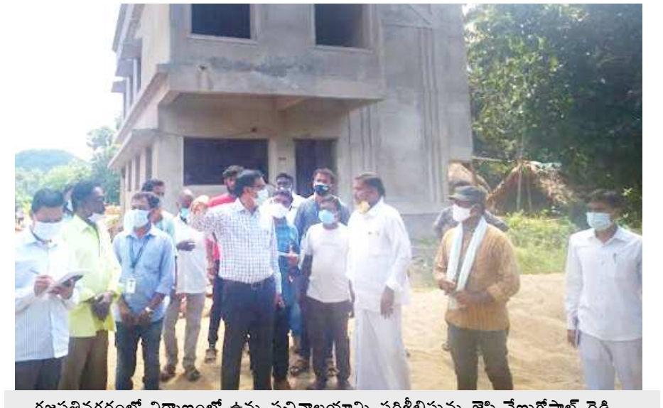
గజపతినగరంలో నిర్మాణంలో ఉన్న సచివాలయాన్ని పరిశీలిస్తున్న జేసీ వేణుగోపాల్ రెడ్డి
