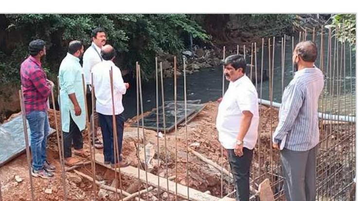
అక్కయ్యపాలెం (విజయభాను న్యూస్) : విశాఖ ఉత్తర నియోజకవర్గం 42వార్డు వైట్ల న్యూ కోలని ఏ.ఆర్ లాడ్జీ వెనుకాల జరుగుతున్న డ్రైనేజి గడ్డ రక్షణ గోడ నిర్మాణ పనులను పరిశీలించిన విశాఖ ఉత్తర నియోజకవర్గ సమన్వయకర్త, రాష్ట్ర నెడ్ క్యాంప్ చైర్మన్ కె.కె రాజు, రక్షణ గోడ నిర్మాణంలో నాణ్యత పాటించాలని జీ ఏ ఏం సి అధికారులను ఆదేశించారు. ఈ కార్యక్రమంలో 42వార్డు కార్పొరేటర్ అళ్ళ లీలావతి శ్రీనివాసరావు, షోర్ లీడర్ బాబాల్ శ్రీనివాసరావు, 42వార్డు అధ్యక్షులు షేఖ్ జుబేర్, జీ-5 EE శ్రీనివాస్, తదితరులు పాల్గొన్నారు.
