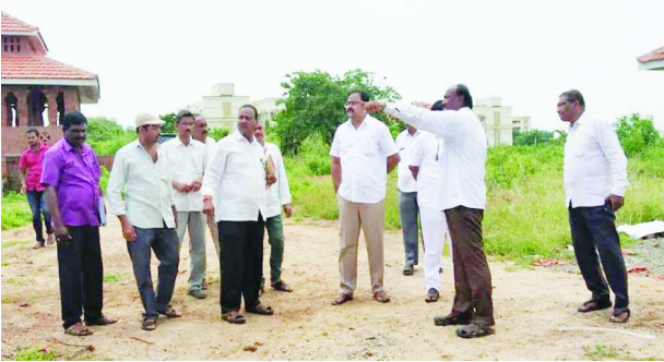
అన్నవరం : తూ.గో.జిల్లా ప్రముఖ పుణ్యక్షేత్రము అన్నవరం శ్రీ వీరవేంకట సత్యనారాయణ స్వామివారి దేవస్థానంలో నిర్మించబడుతున్న వేదపాఠశాలను దేవస్థానం కార్యనిర్వహణాధికారి ఎ.త్రినాధరావు దేవస్థానం ఇంజనీరింగ్ విభాగం అధికారులతో కలిసి నిర్మాణ పనులను పరిశీలించారు.
